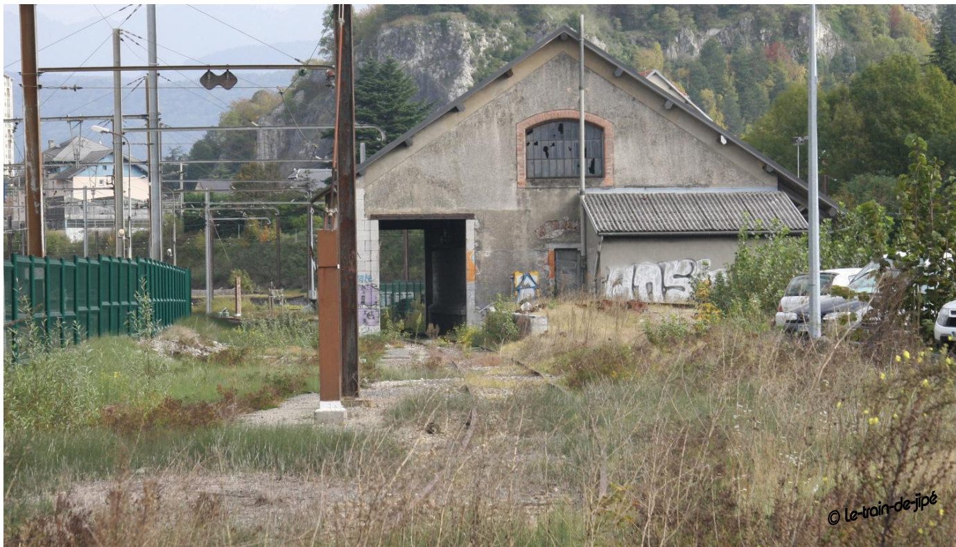
Vue rapprochée de la halle marchandise. On devine le quai.
