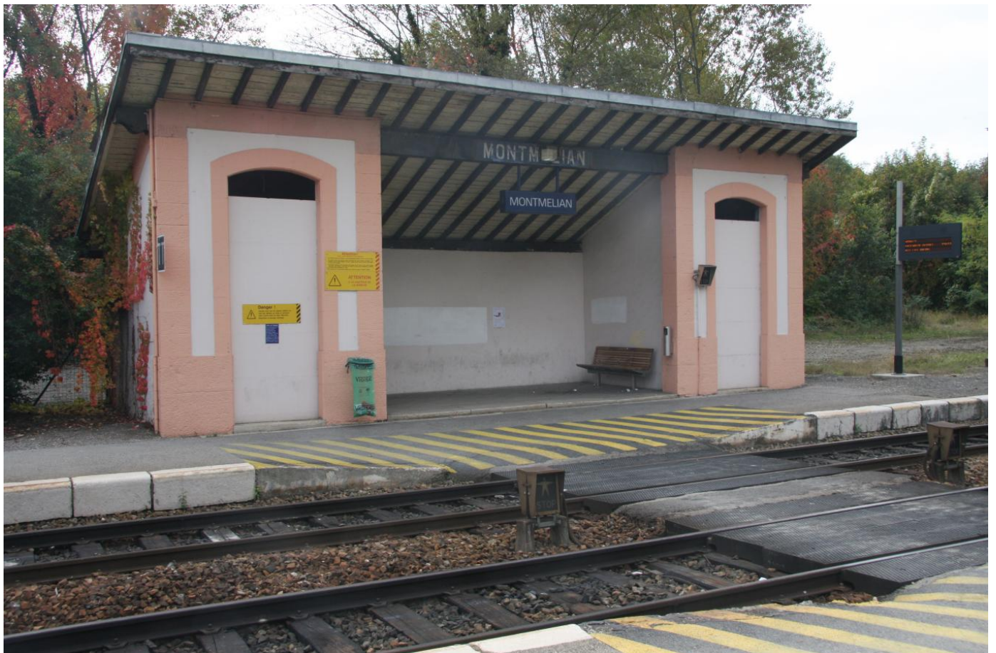
Abri des voyageurs à destination de Chambéry.
