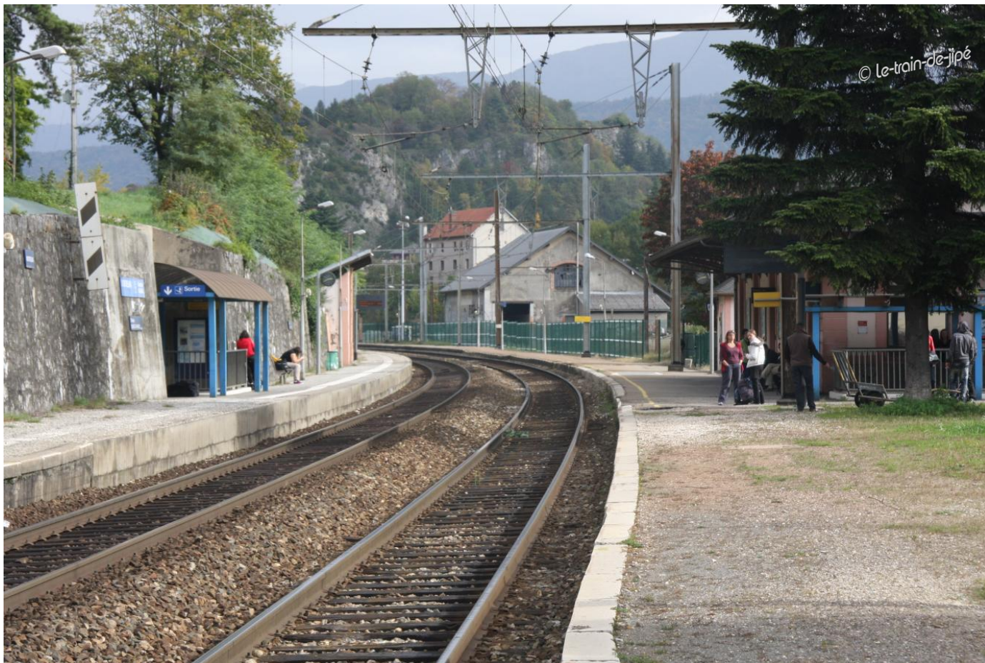
Les quais direction Chambéry depuis Bourg Saint Maurice, et depuis Chambéry. Notez le passage souterrain. Au loin on voit la vieille halle marchandises désaffectée.
