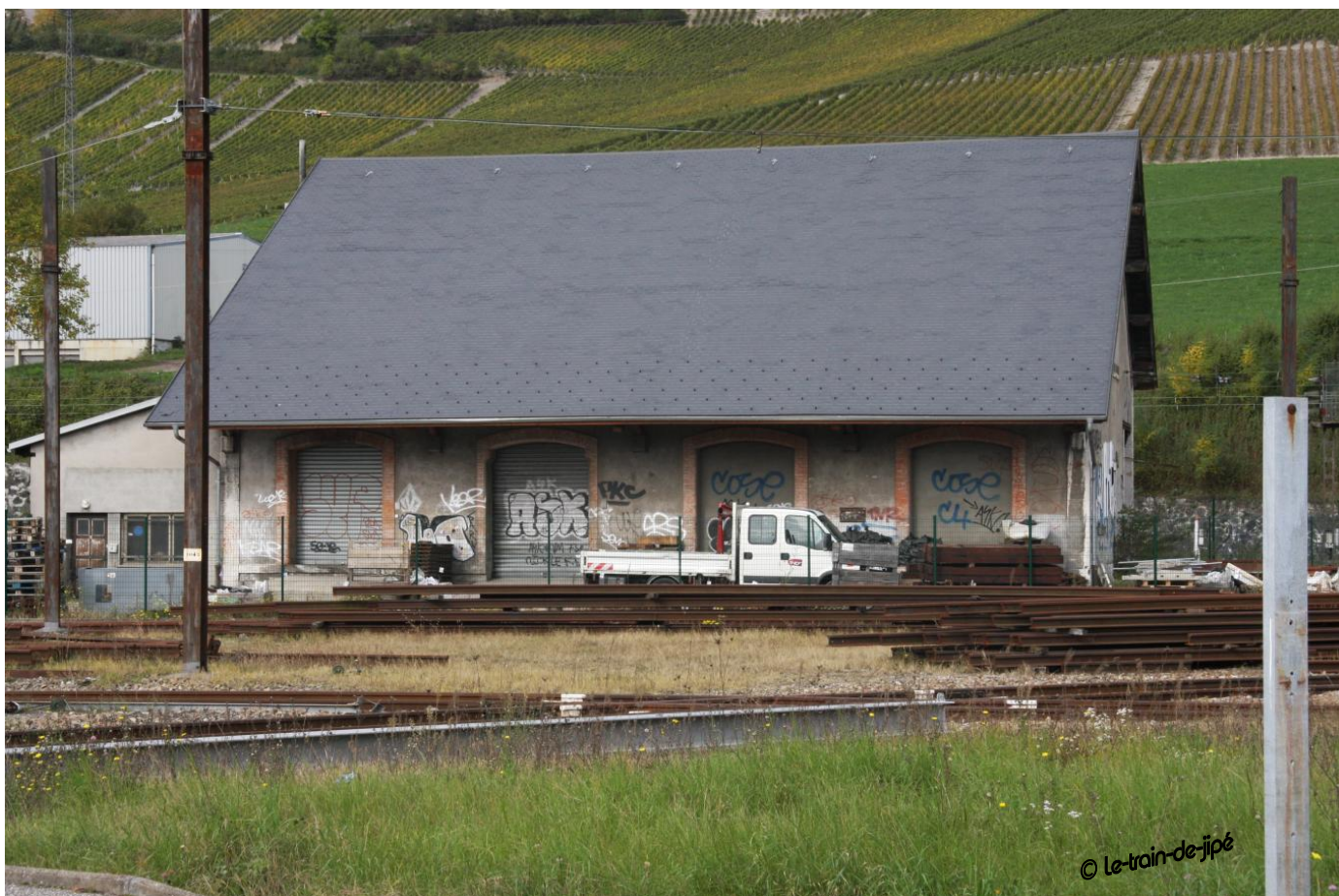
La halle est reconvertie en bâtiment pour l'équipement SNCF.
