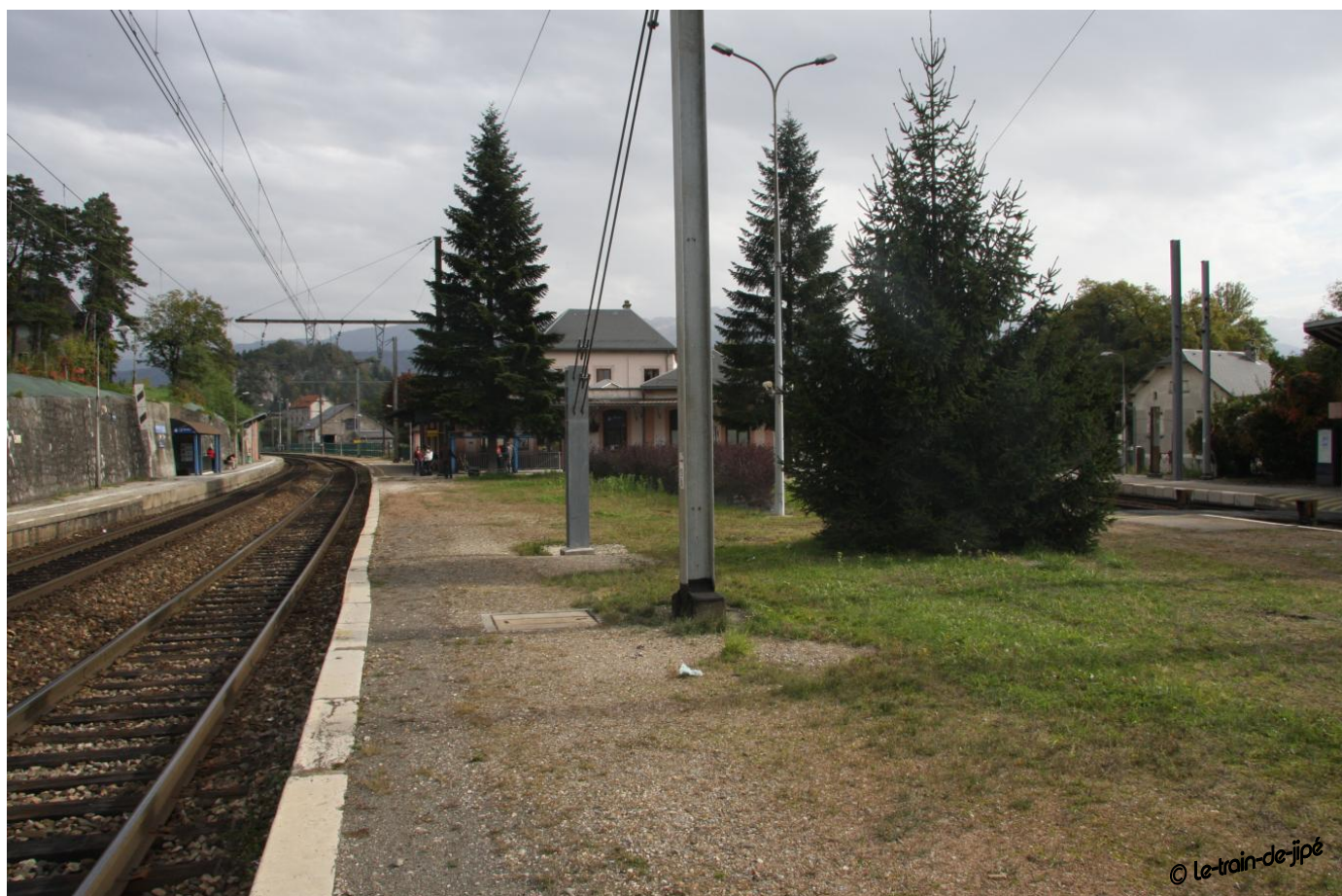
Vue vers la direction Bourg Saint Maurice/Modane. A droite vers Grenoble.
